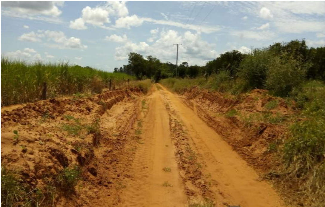
Fotografia 4: trecho com erosão e estreitamento da pista de rolamento.
