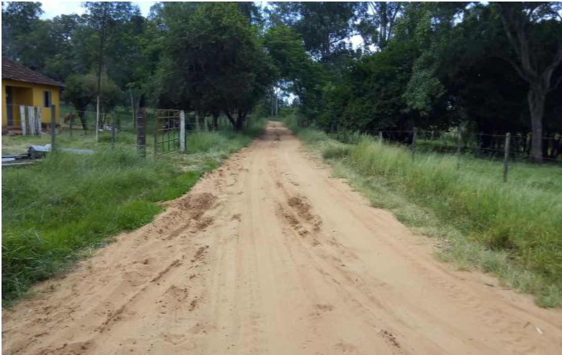
Fotografia 2: Trecho com presença de areião de baixada.
