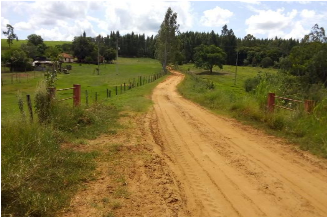
Fotografia 3: Trecho com falta de estruturas de drenagem e armazenamento de água.
